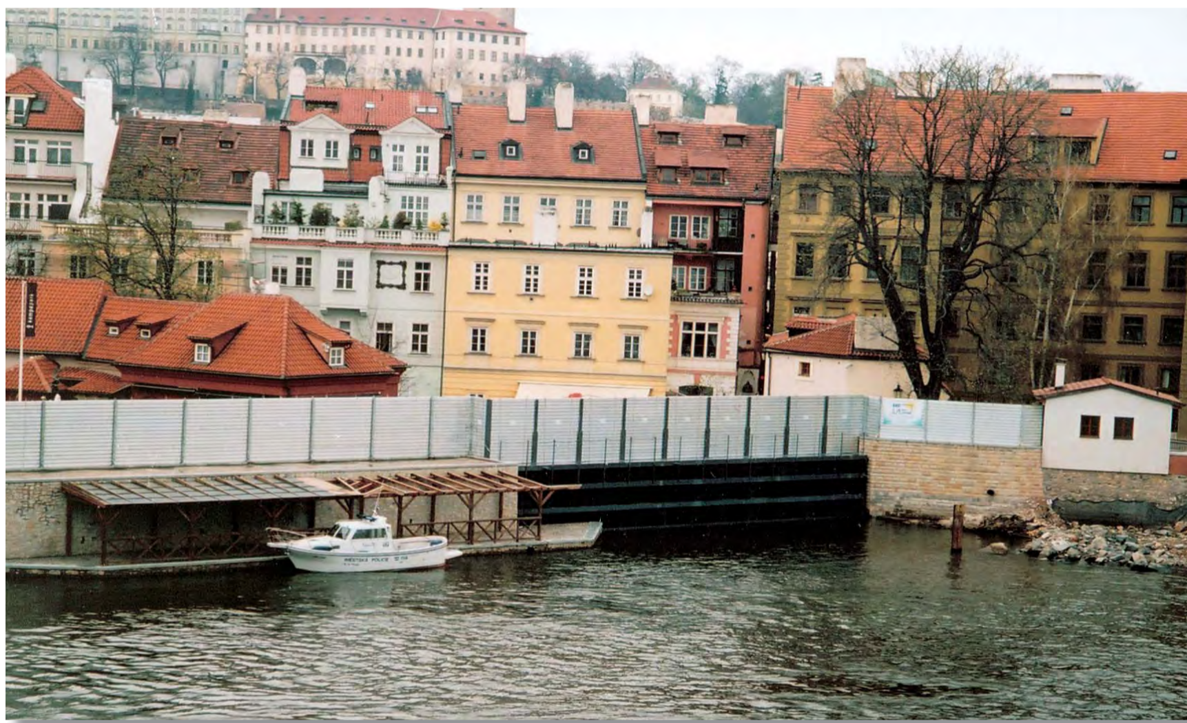
Protipovodňový uzávěr Čertovky - Praha (Česká republika) Flood gate Čertovka - Prague (Czech Republic) Затвор против наводнения река Чертовка - Прага (ЧР)
